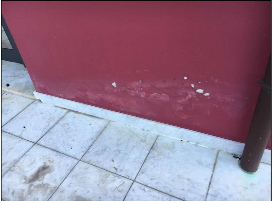
FOTO 3 - VISTA DEL DEGRADO DELL'INTONACO ESTERNO
