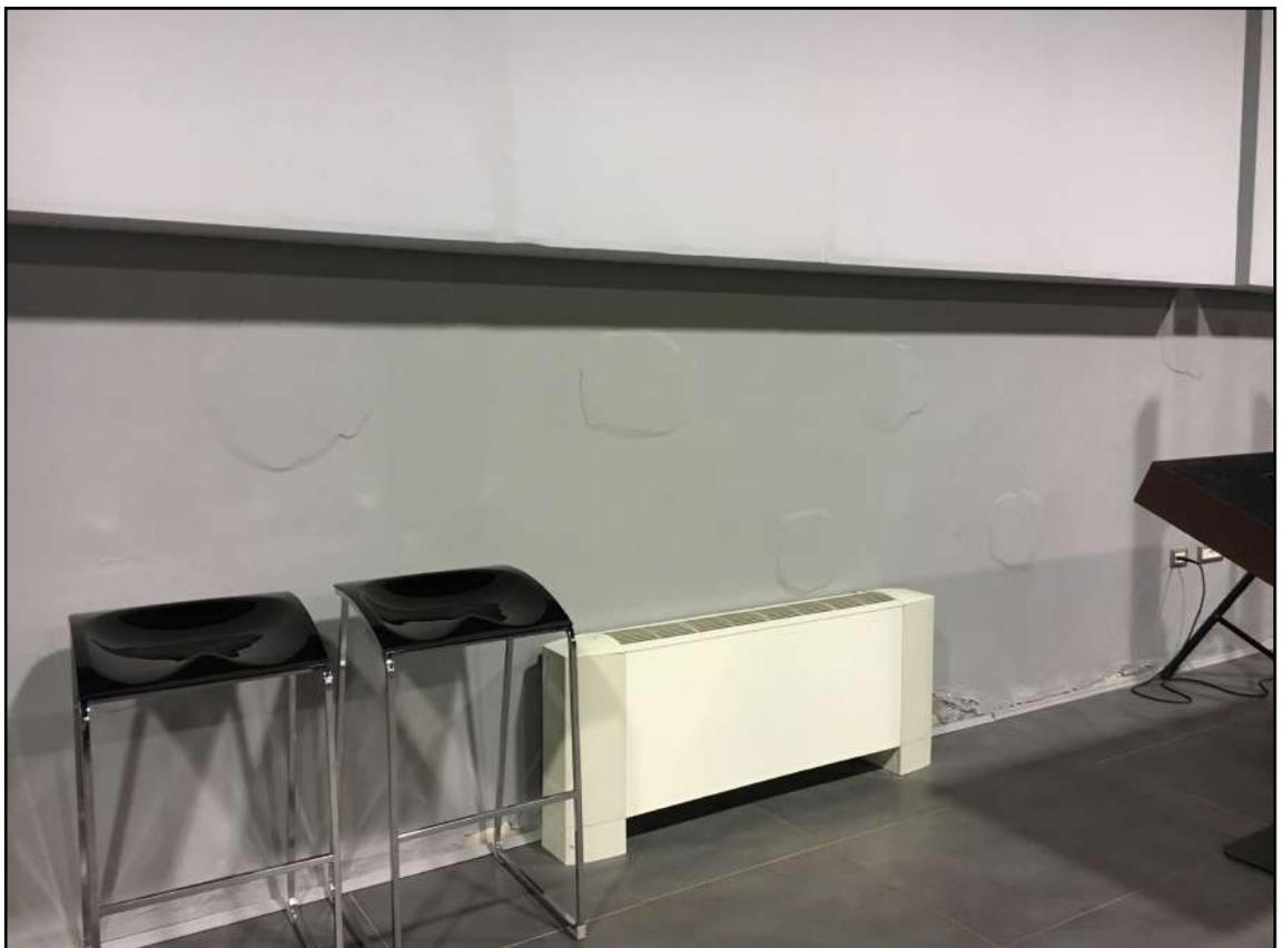
FOTO 4 - VISTA DEL DEGRADO DELL'INTONACO INTERNO
